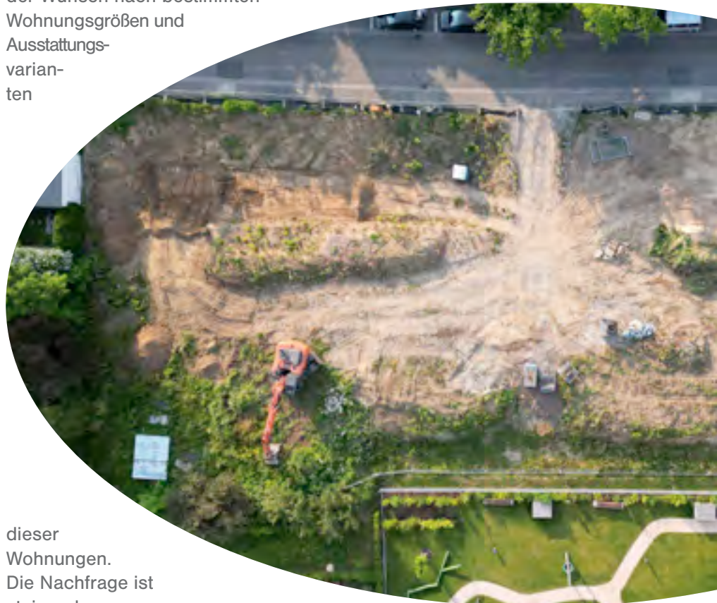
Adolf-Kolping-Straße nach dem Abriss
