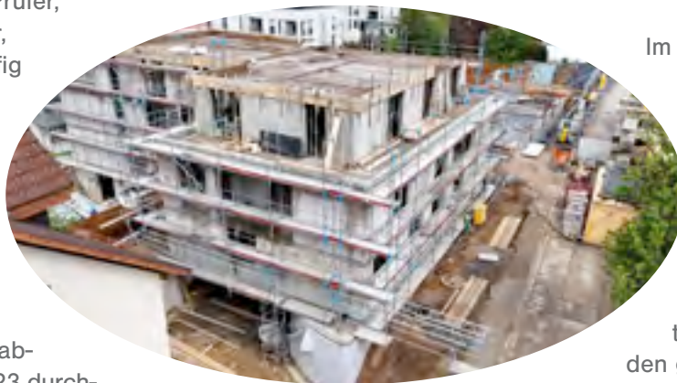
Adolf-Kolping-Straße Bauabschnitt I Rohbau
