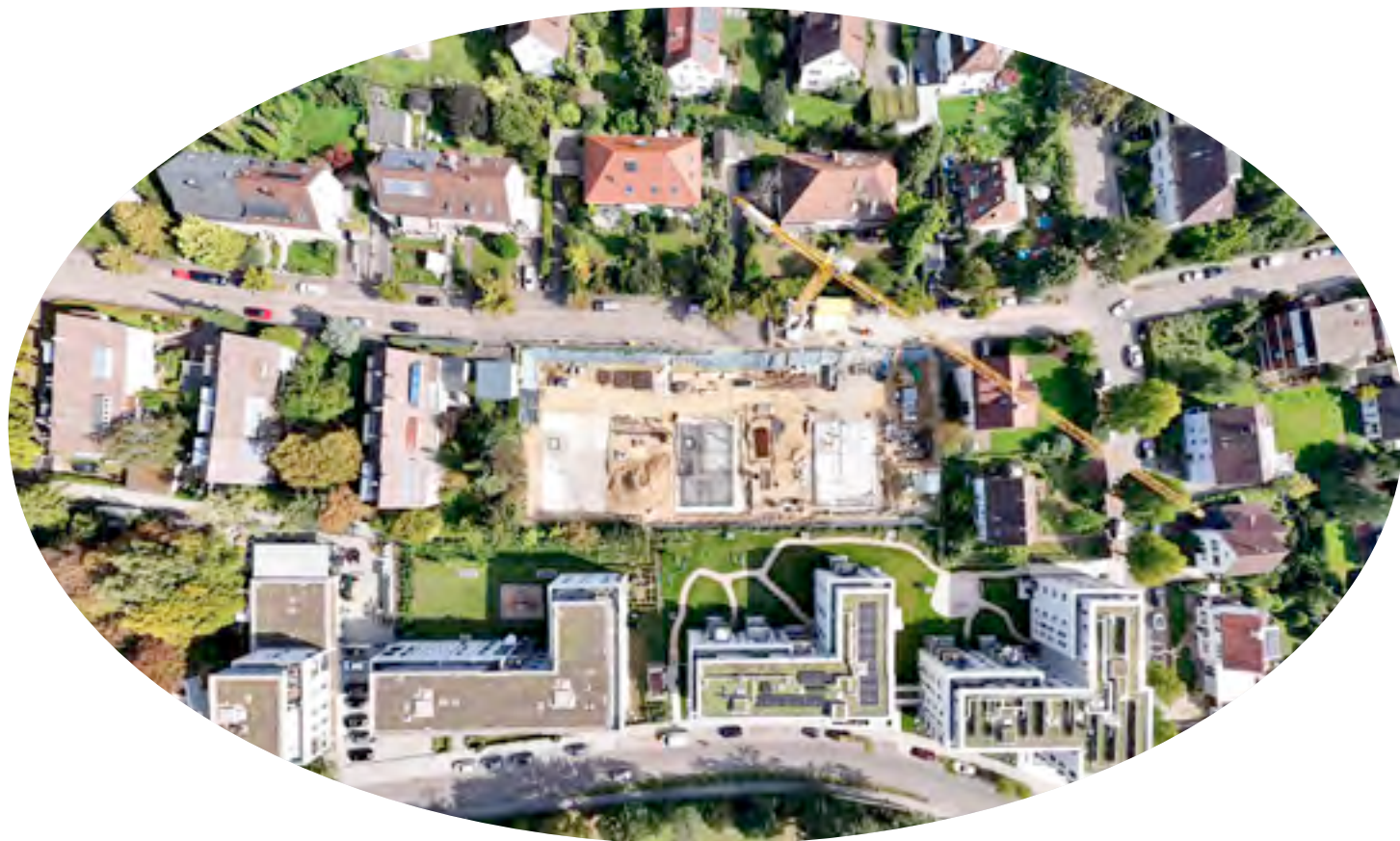
Adolf-Kolping-Straße Bauabschnitt I bis III
